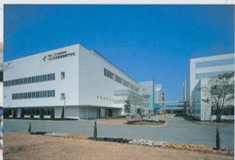
充実した施設・設備(平成18年)
